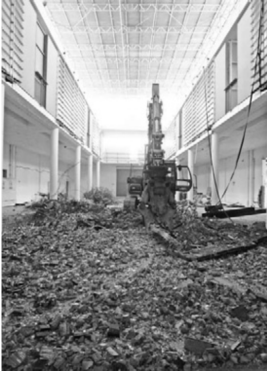
Ausstellungshalle Spike Island im Umbau, März 2006
